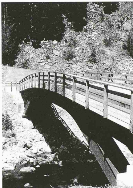
Neue Möglichkeiten eröffnet der Holz-Beton-Verbund dem Brückenbau. Bei ungedeckten Holzbrücken wie der Crestawaldbrücke bei Sufers GR schützt die betonierte Fahrbahn das untenliegende Tragwerk aus Holz auf ideale Weise (Projekt: Werner Zöllig AG, Arbon, Krattiger Holzbau-Engineering, Happerswil; Beratung: Institut für Baustatik und Konstruktion ETHZ; Bild: Archiv Lignum/SAH, Anton Steurer, ETHZ)
