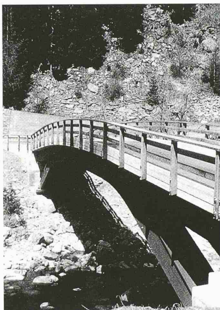
Neue Möglichkeiten eröffnet der Holz-Beton-Verbund dem Brückenbau. Bei ungedeckten Holzbrücken wie der Crestawaldbrücke bei Sufers GR schützt die betonierete Fahrbahn das untenliegende Tragwerk aus Holz auf ideale Weise (Projekt: Werner Zöllig AG, Arbon, Krattiger Holzbau-Engineering, Happerswil; Beratung: Institut für Baustatik und Konstruktion ETHZ; Bild: Archiv Lignum/SAH, Anton Steurer, ETHZ)
