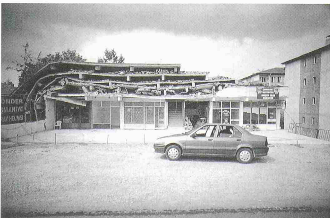
5 Komplettes Versagen eines Gebäudes («pancake»-Schaden)
