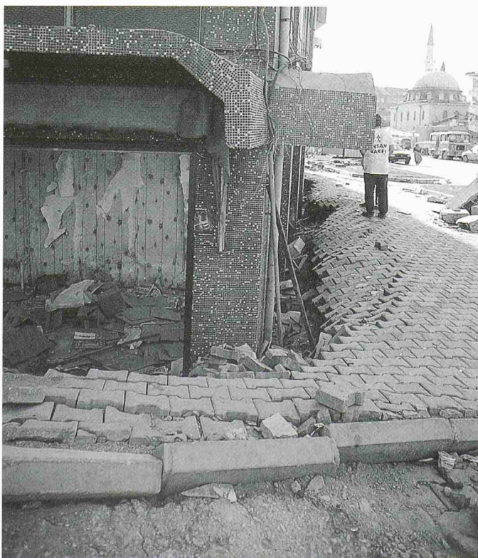
Adapazari: Einsinken eines Gebäudes und Aufwölben infolge Materialumlagerungen
