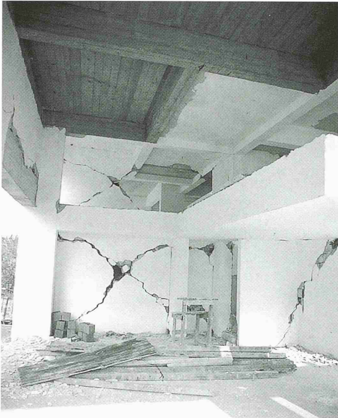
3 Kreuzrisse in einer nichttragenden Mauerwerkswand
