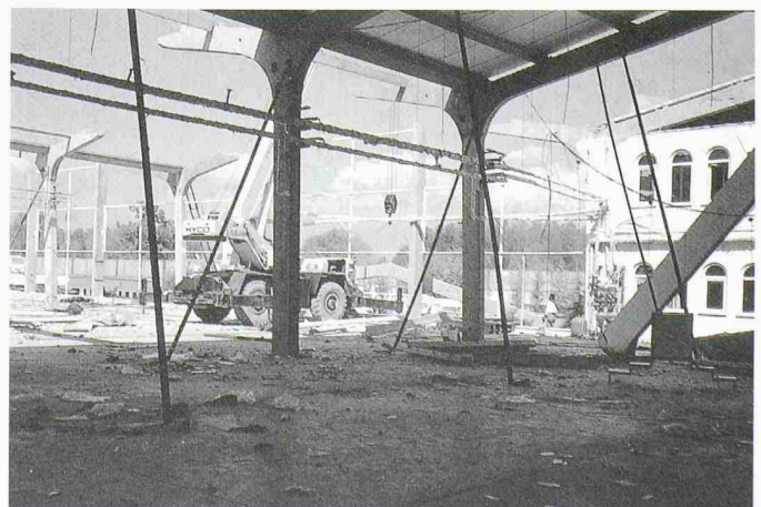
13 Die Querrahmen der vorfabrizierten Kon- struktion scheinen weitgehend intakt. Sämtliche Rahmen- stiele sind jedoch im untersten Drittel durch einen Schub-/Biege- bruch irreparabel beschädigt
