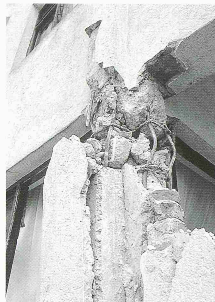
Konstruktionsdetail: Verbindung Stütze-Balken
