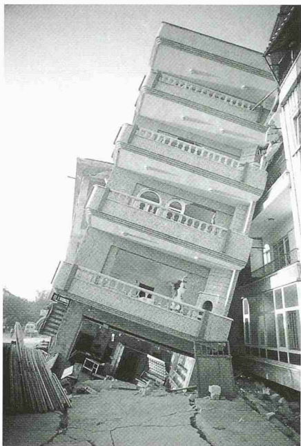
Adapazari: Fundationsversagen infolge Bodenverflüssigung
