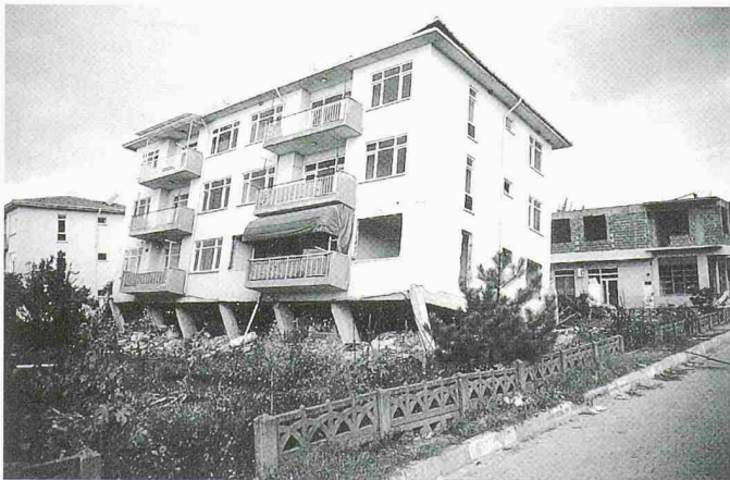
4 Totalschaden infolge zu schwach ausge- steiften Erdgeschoss- ses («soft storey»- Schaden)
