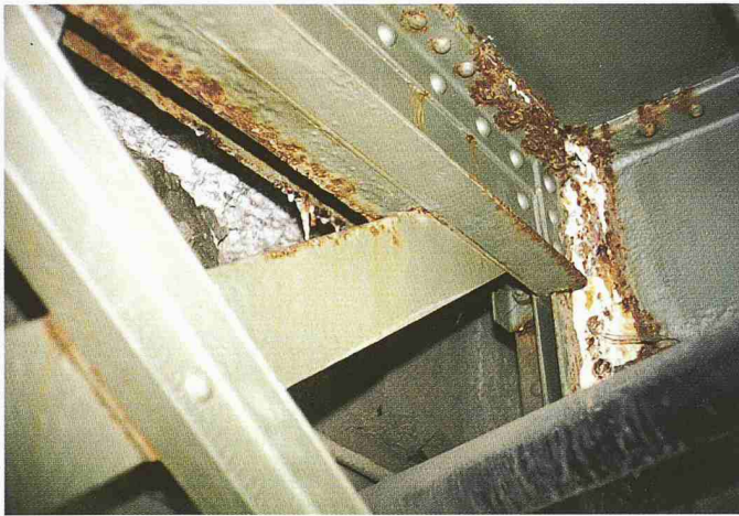
Korrosionsschäden an der Stahlkonstruktion
