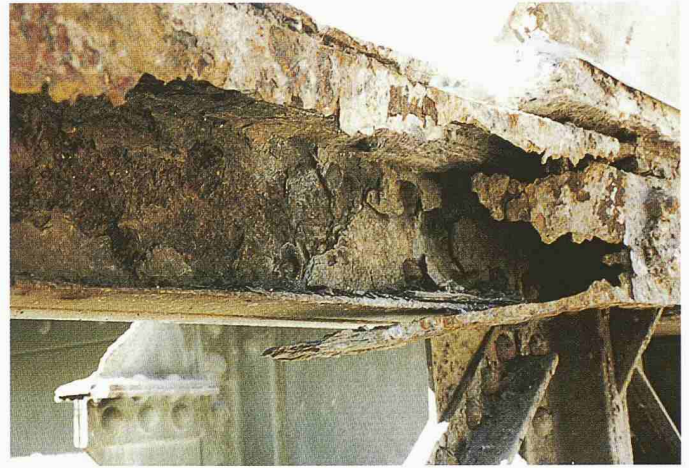
Endquerträger: Überreste des Obergurts nach 100 Jahren Korrosion
