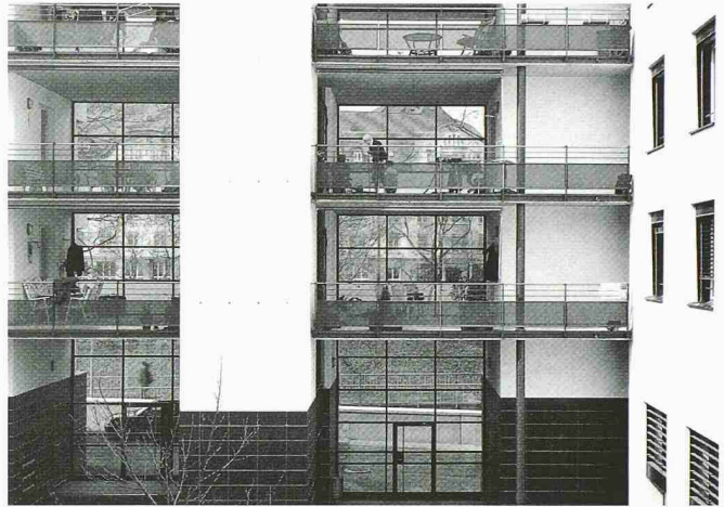
2 Die lärmexponierte Seite ist durch Erschliessungstrakte und verglaste Wohnterrassen gegen den Strassenlärm abgeschirmt. Siedlung Selnau, Zürich. Martin Spühler, Architekt, Zürich (Bild: Christian Kurz, Zürich)
