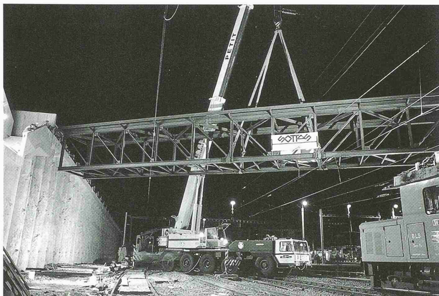
Montage der neuen Passerelle in der Nacht (Bild: G. Lauper, Spiez)
