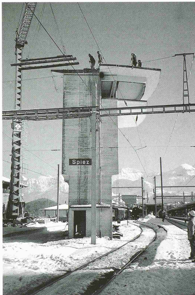
10 Abbruch des Stellwerks im Gleisfeld (Bild: G. Lauper, Spiez)
