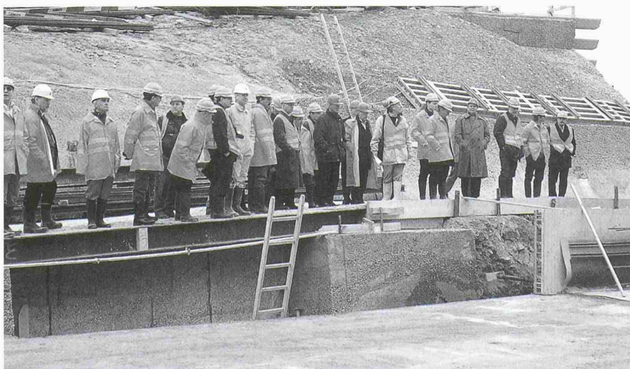
Baustelle der Bahn 2000 Zürich-Thalwil
