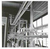
zung, Druckluft usw.) rasch und einfach montiert werden können. Das gesamte Lanz-Kabelträgermaterial ist auch aus rostfreiem Stahl V2A und V4A für den Lebensmittelbereich und für die chemische Industrie lieferbar.
