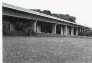
A1 Viadukt Löwenberg
