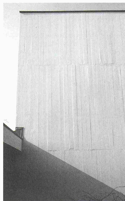
Aussenwand nach Instandsetzung (starres System)
