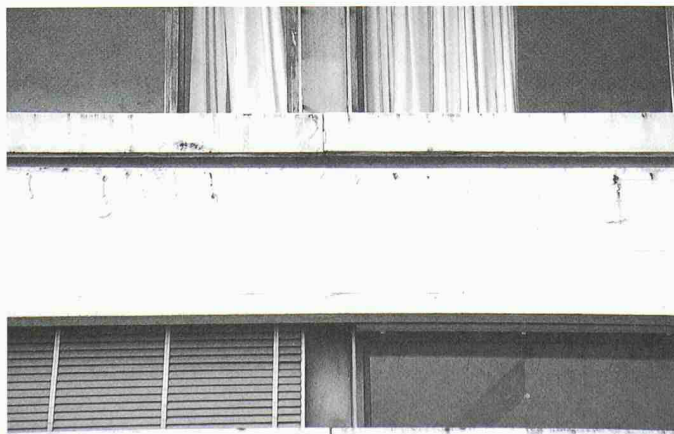
3 Typisches Schadens- bild an den Längsbän- dern des Klassentrakts
