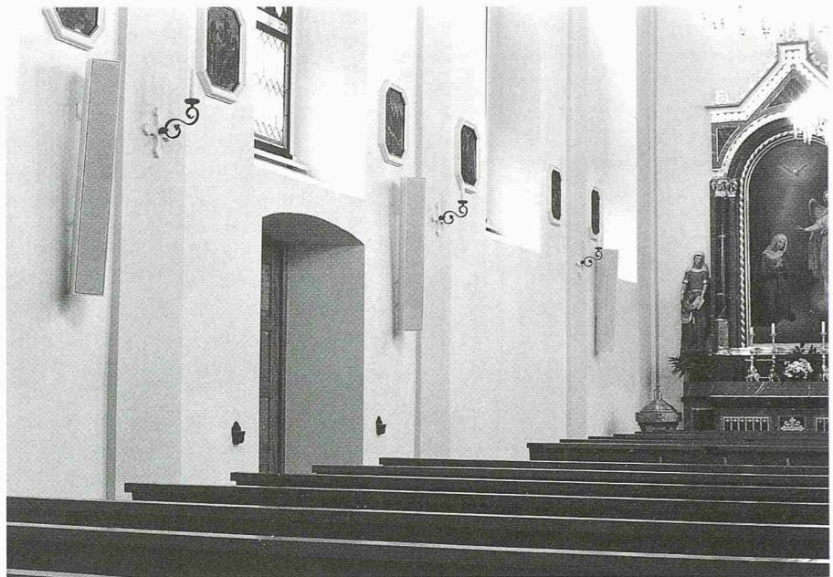
Lautsprecherzeilen in der katholischen Kirche Zufikon: Starke Richtwirkung bei guter Klangqualität
