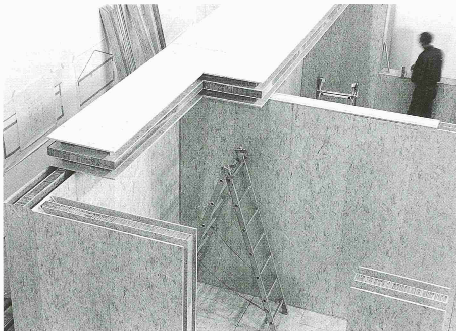
Das Modulhaus aus Altpapier entsteht im Baukastenprinzip. Im Bild ein standardisiertes einfaches Haus, wie es beispielsweise in Katastrophengebieten rasch errichtet werden kann. Deutlich zu sehen sind die Papierwaben in Plattenmitte
