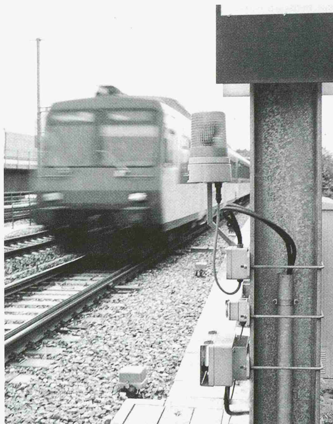
5 Warnmittel und Bedienstelle montiert an Fahrleitungsmast, im Hintergrund PWA-Steuerschrank
