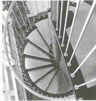
Holz, schwarz lackiert, und Stahl sind bei dieser Spindeltreppe kontrastreich kombiniert
