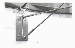
spannungszustand, wobei die Vorspannung so gewählt wurde, dass die Gegenkabel nie Druck erleiden. Die Struktur weist also aufgrund der beiden Kabelarten stets eine bestimmte Steifigkeit auf.
