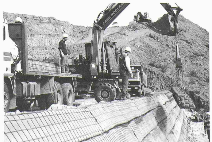
3 Montage der Gabionen mit dem Einbaukran direkt vom Camion, eine besonders schnelle und effiziente Methode
