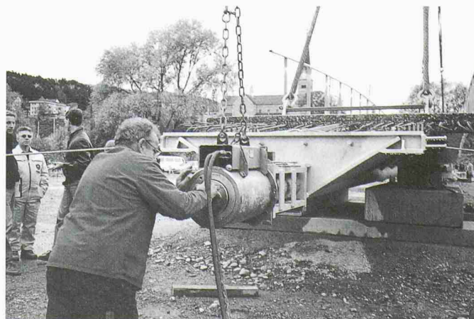
Spannstuhl auf Auflagerscheiben beim Vorspannen der CFK-Kabel
