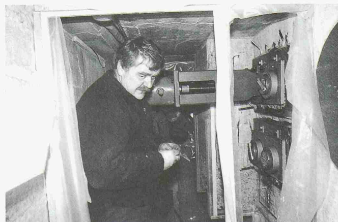
10 Spannen der Karbonkabel in der Widerlagerkammer Seite Camedo (Bild: Empa)
