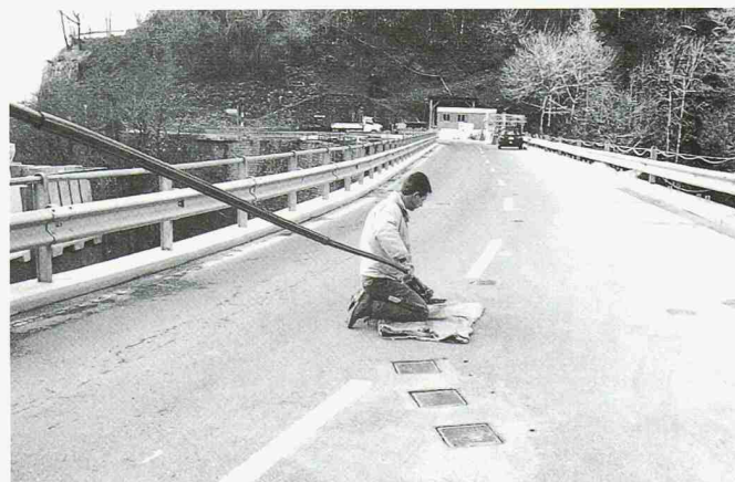
9 Einziehen der Karbonkabel in den Kasten (Bild: Empa)
