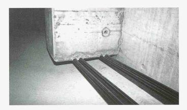
7 Nachträglich einbetonierte Kabel-Umlenkstelle im Feld
