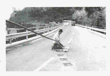
9 Einziehen der Karbonkabel in den Kasten (Bild: Empa)
