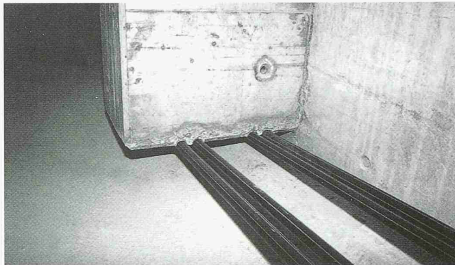
7 Nachträglich einbetonierte Kabel-Umlenkstelle im Feld
