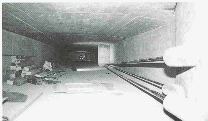
8 Externe Karbon-Vorspannung im Widerlagerbereich Seite Camedo
