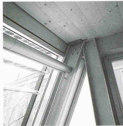
3 GFK-Profile in der Fassadenebene, Detail Innenansicht
