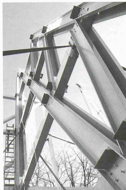
5 Zangenbauweise der GFK-Struktur
