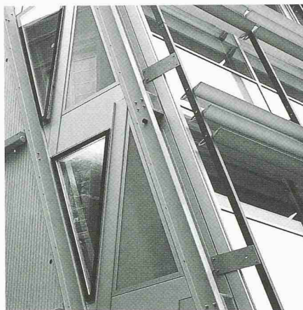
2 GFK-Profile in der Fassadenebene, Detail Aussenansicht
