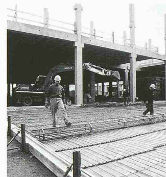
Sofern die Bamtec-Rollen ein Gesamtgewicht von 1,3 Tonnen nicht überschreiten, können sie mühelos von zwei Arbeitern ausgerollt werden
