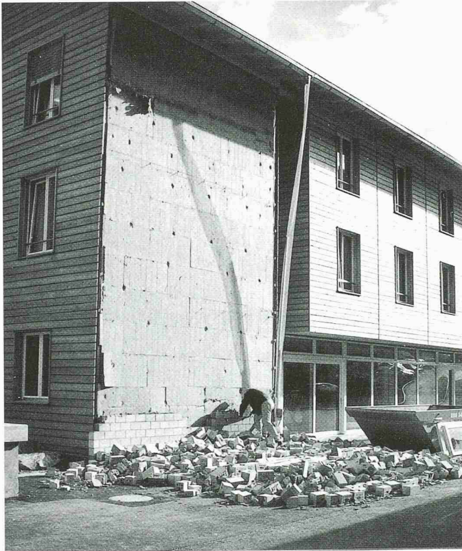
Eingestürzte Kalksandsteinwand an der südwestlichen Seite des Gebäudes
