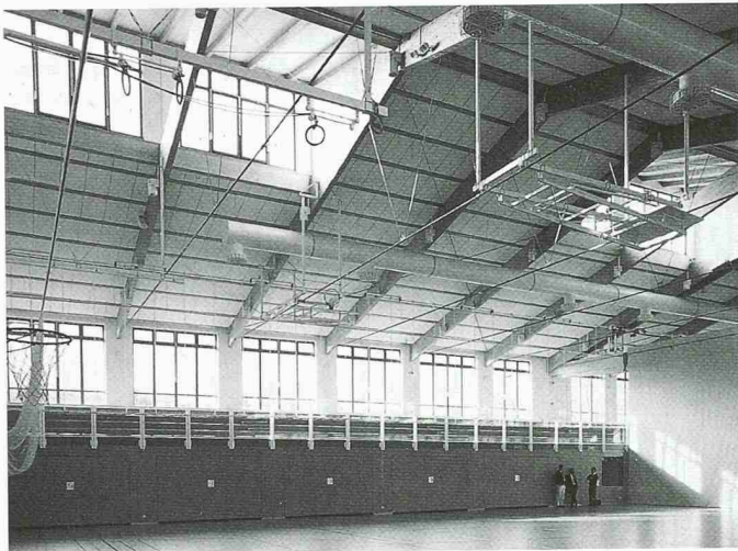
Der Sporthallenbau ist ein wichtiges Einsatzfeld für Dachelemente. Der Nachweis der Ballwurfsicherheit gem. DIN 18032, Teil 3, erleichtert die Planung solcher Hallen
