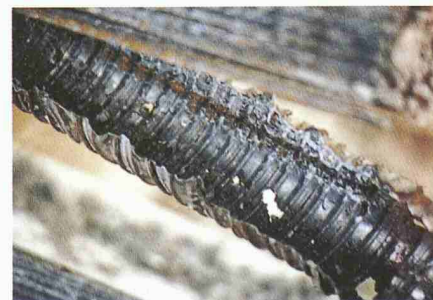
Die Innenseite des Hüllrohrs ist bei vorhandenem, kompaktem Injektionsgut blank und weist bei poröserem oder fehlendem Injektionsgut Korrosionsspuren und Ausblühungen auf
