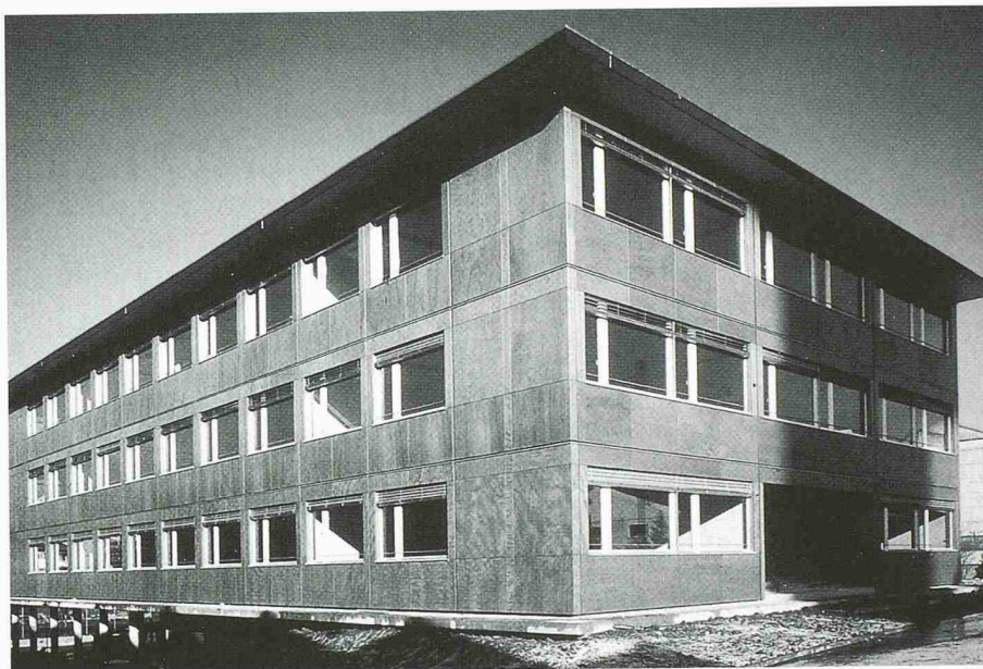
Beim neuen Forschungsgebäude der Firma Schindler kam eine modulare Holzbauweise zum Einsatz. Gleichzeitig dient es zur Präsentation eines neuartigen Aufzugssystems (Bild: Hans Ege)
