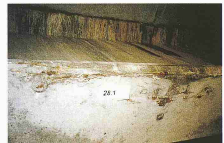
5 Schäden an Elementträger Nr. 1 und 5 (unten)
