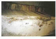
den Dilatationsfugen analoge Schäden wie die Elementträger auf.
