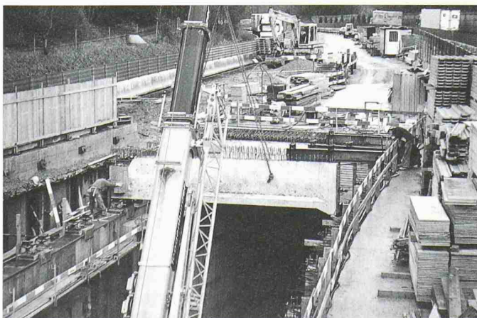
Montage Elementträger Teil 2, Phase 6a
