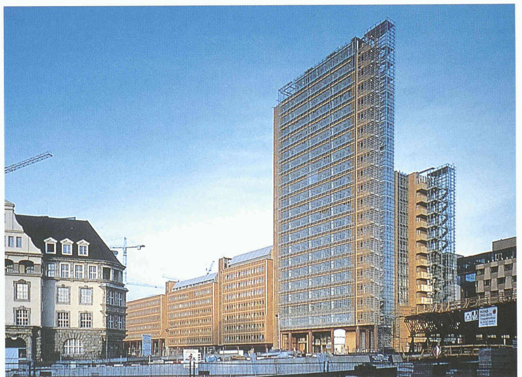
Debis-Hochhaus vom Landwehrkanal aus gesehen. Angrenzend: Berliner Volksbank (Isozaki/Lehmann) und Canaris-Haus
