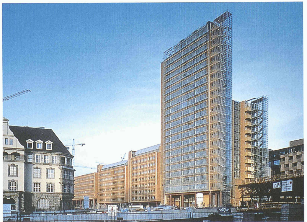
Debis-Hochhaus vom Landwehrkanal aus gesehen. Angrenzend: Berliner Volksbank (Isozaki/Lehmann) und Canaris-Haus
