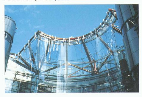
momente um das Bohrungsloch zu verhindern, sind Kugelgelenke, die in der Glasachse liegen, in die Befestigungsknoten eingebaut.
