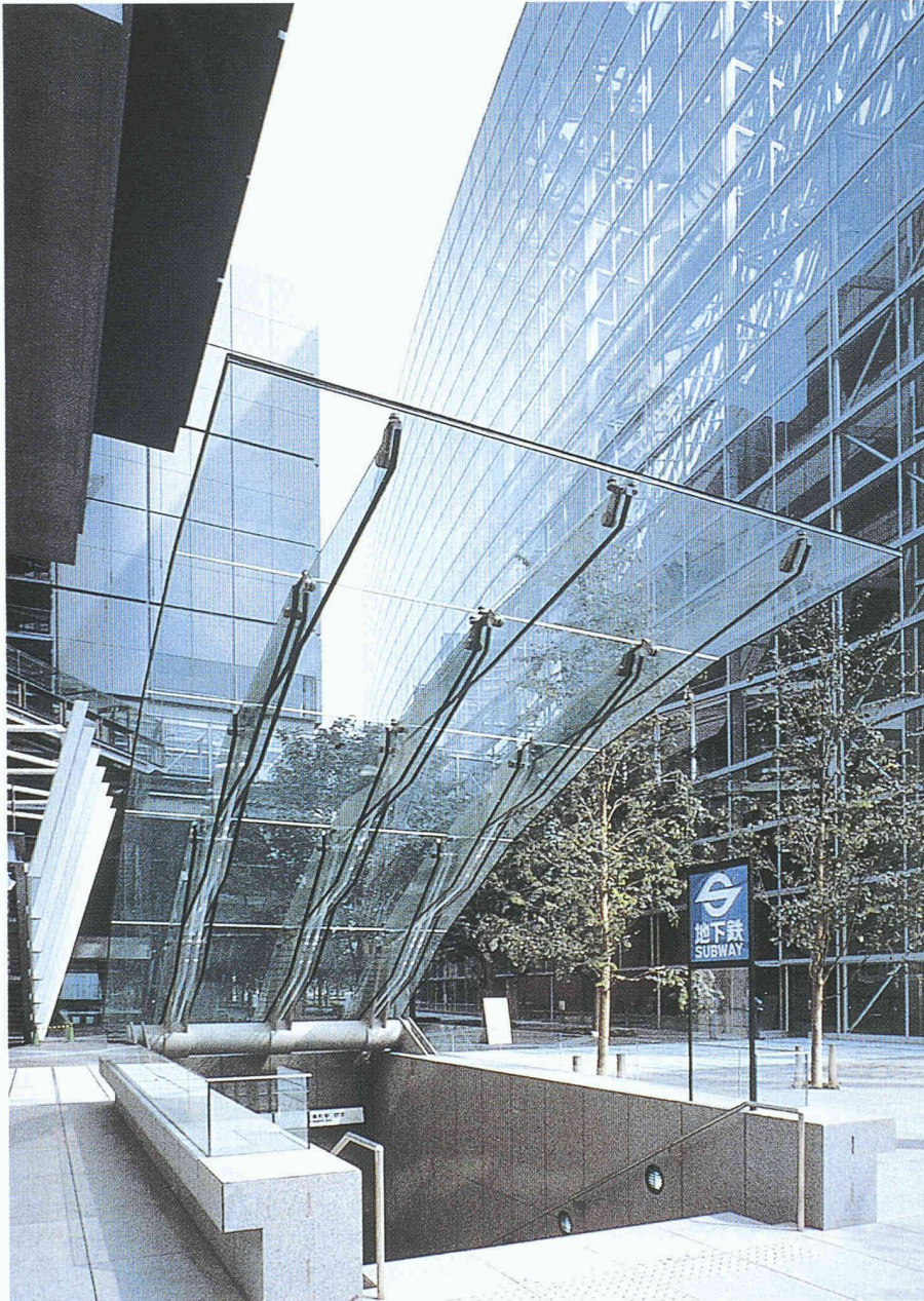
Yurakucho-U-Bahn-Station, Tokio 1996. Architekten Rafael Vinoly Architects mit Dewhurst Macfarlane und Partner
