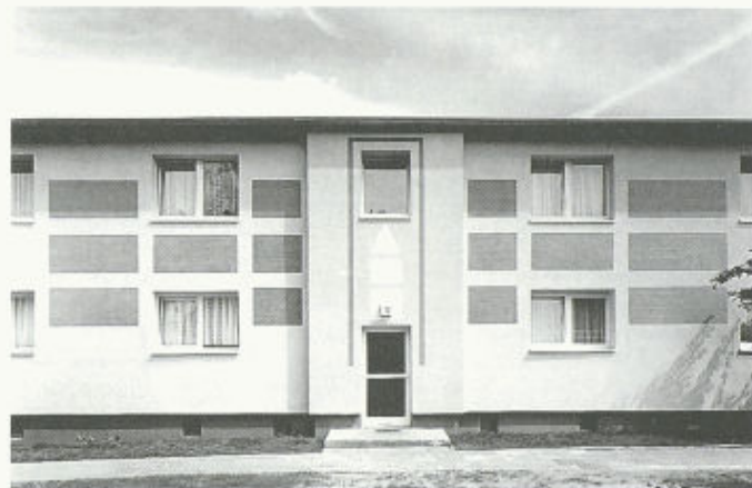
Wärmedämm-Elemente StoTherm Solar an einem Mehrfamilienhaus
