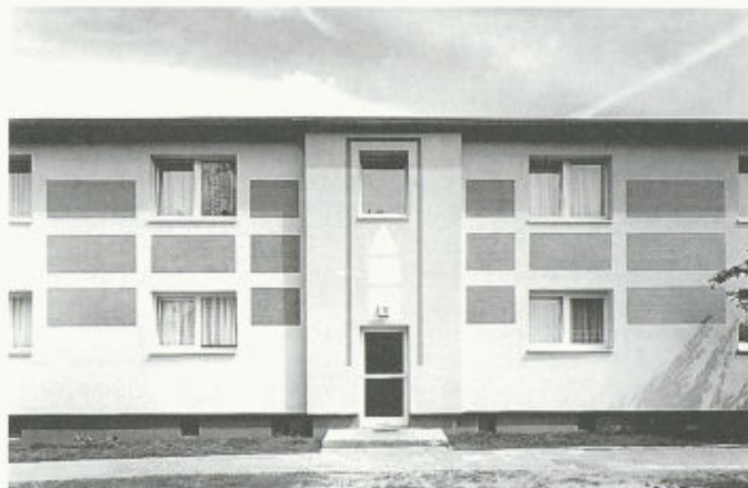
Wärmedämm-Elemente StoTherm Solar an einem Mehrfamilienhaus
