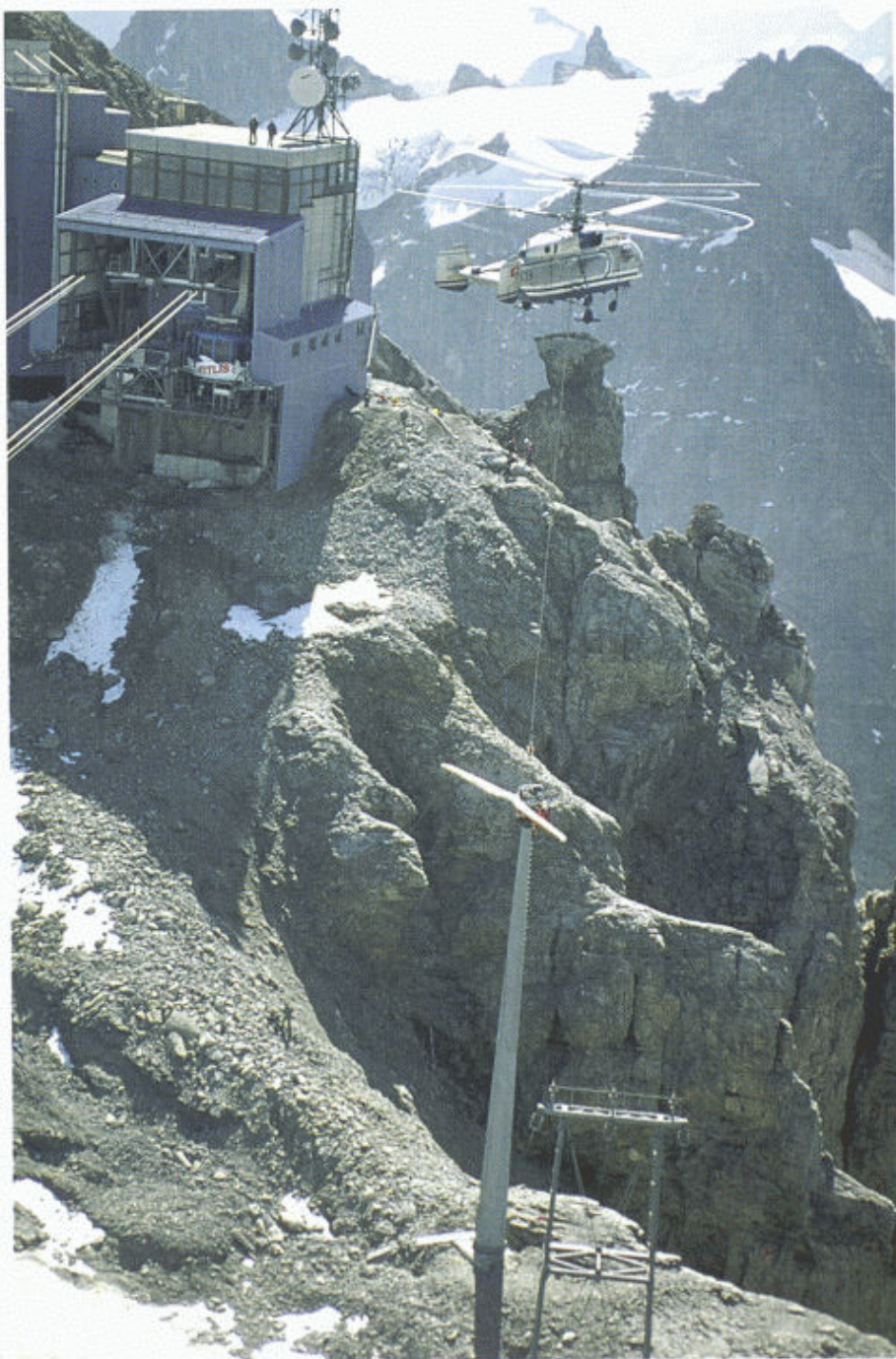
Präzisionsarbeit auf 3000 Meter Höhe: Für die Montagearbeiten der 30-kW-Anlage auf dem Titlis wurde der leistungsfähigste Lastenhelikopter der Schweiz benötigt. Dreimal musste der russische Hubschrauber Karnov KA-32 vom Sustenpass herkommend mit tonnenschwerer Last bergan fliegen; nach wenigen Stunden waren Mast, Rotor und Generatorkabine millimetergenau gesetzt, und bereits am folgenden Tag erzeugte Europas höchstgelegene netzgekoppelte Windkraftanlage Strom (Bilder: August Pfluger)
