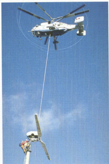
Präzisionsarbeit auf 3000 Meter Höhe: Für die Montagearbeiten der 30-kW-Anlage auf dem Titlis wurde der leistungsfähigste Lastenhelikopter der Schweiz benötigt. Dreimal musste der russische Hubschrauber Karnov KA-32 vom Sustenpass herkommend mit tonnenschwerer Last bergan fliegen; nach wenigen Stunden waren Mast, Rotor und Generatorkabine millimetergenau gesetzt, und bereits am folgenden Tag erzeugte Europas höchstgelegene netzgekoppelte Windkraftanlage Strom (Bilder: August Pfluger)
