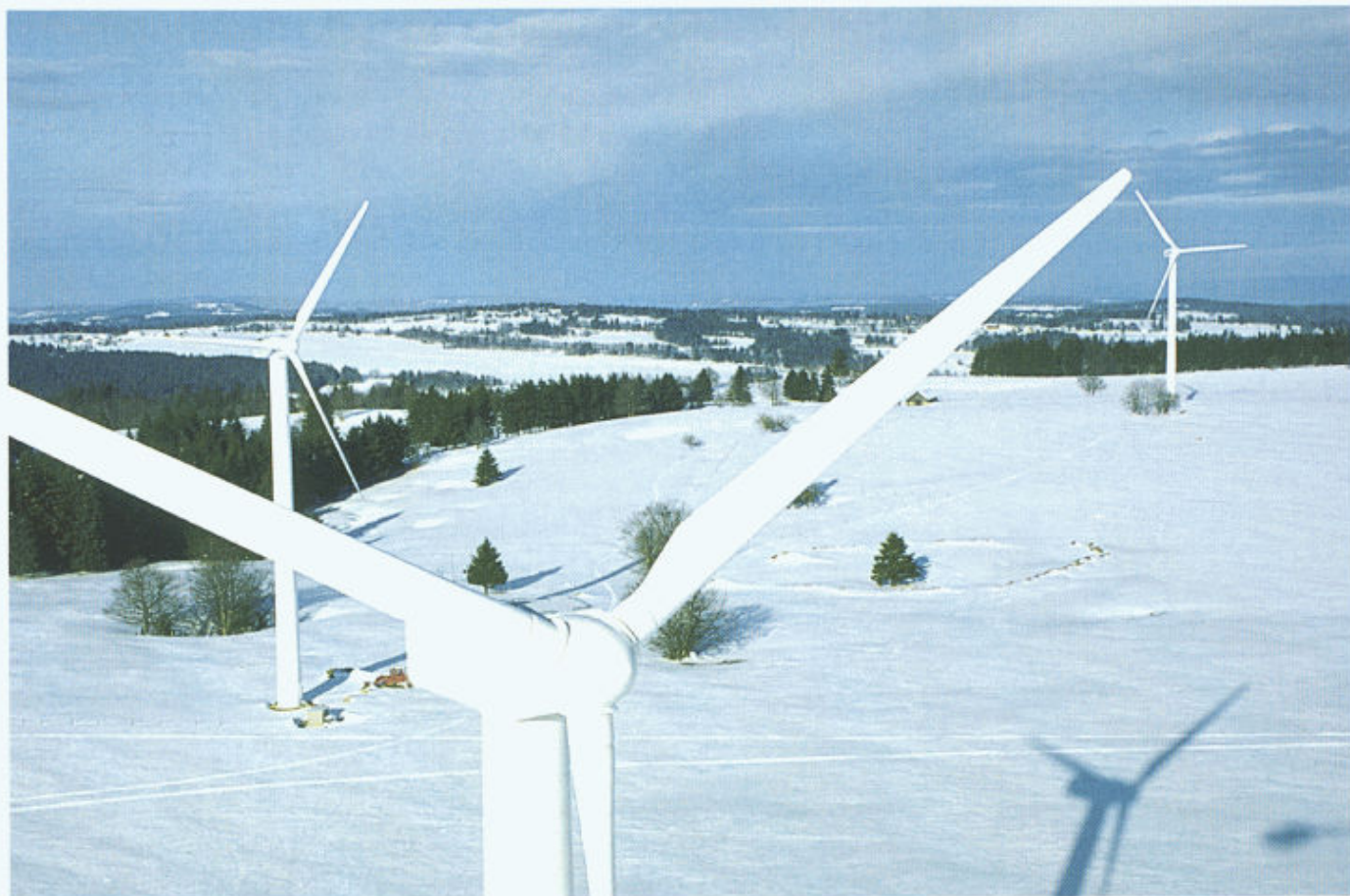
Auf dem Mont Crosin im Berner Jura befindet sich die grösste Schweizer Windkraftanlage (Bild: August Pfluger)
