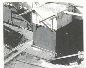
Grundmauerschutz mit Teguplast-Noppenbahn
