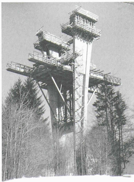
3 Lehrgerüst Grundetappe mit Freivorbauwagen während Montage bei Pfeiler P4
