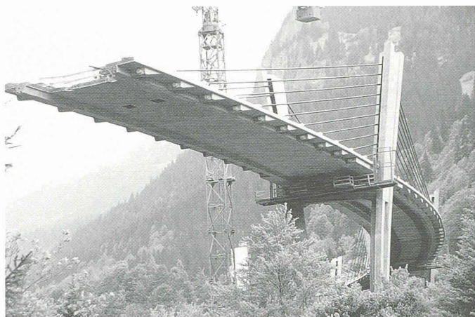
Pfeiler/Pylon 3 und Freivorbau Richtung Pfeiler 4
