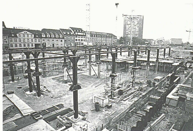
Hauptstützen im Untergeschoss mit Montageaussteifung
