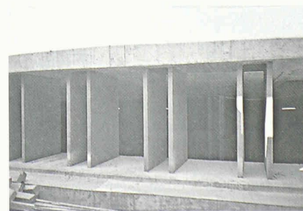
Randaufleger in den äusseren Gebäudeabschnitten. Biegeeweiche Konstruktion für die Längsrichtung aus 60 mm starken Lamellen aus FeE 460
