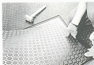
Paviblock: Verlegung
