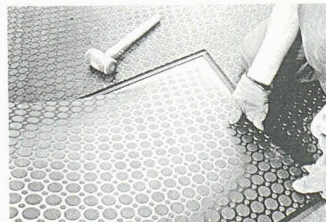
Paviblock: Verlegung
