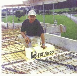
Auf passende Grösse zuschneiden, einlegen und in Decke einbetonieren.
