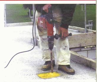
Erst bei Bedarf mit Leichtigkeit trocken bohren, dann Leitungs-Rohre und Kabel einführen.
