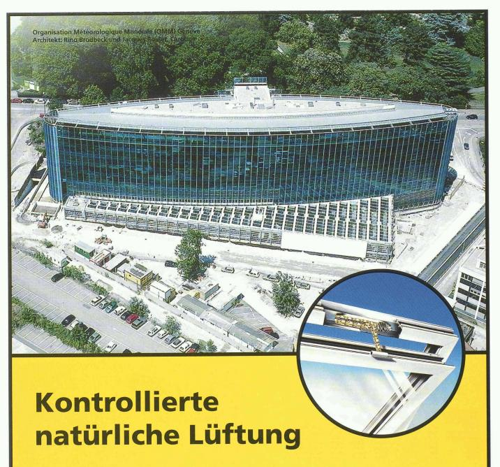
Basis dieses Konzeptes ist das innovative **WindowMaster-Belüftungssystem**: eine massgeschneiderte Technologie, die Sensoren, Steuerung und «unsichtbar» ins Fensterprofil integrierte elektrische Fenstermotoren umfasst.
