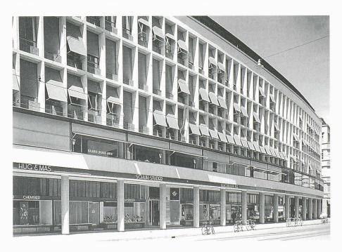
tes, selbsttragendes Aluminiumnetz konzipiert, das die Fensterverglasung wie die gläsernen Brüstungsplatten aufnimmt.11
