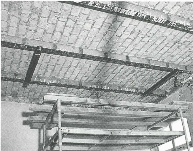
Seminar Unterstrass: Untersicht der mit speziellen Hourdissteinen liegend ausgemauerten Deckenfelder im Ausmass von 1,34 m Breite und 4,70 m Länge. In der Bildmitte befinden sich noch die rückverankernden Stahltraversen der Belastungseinrichtung
