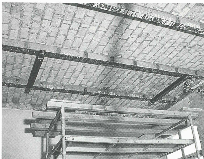
3 Seminar Unterstrass: Untersicht der mit speziellen Hourdissteinen liegend ausgemauerten Deckenfelder im Ausmass von 1,34 m Breite und 4,70 m Länge. In der Bildmitte befinden sich noch die rückverankernden Stahltraversen der Belastungseinrichtung
