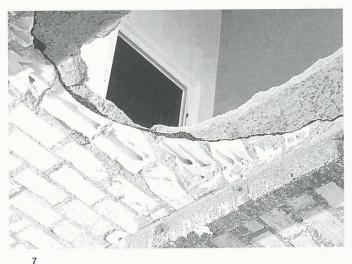
Seminar Unterstrass: Schliessliche Durchstanzstelle im Detail. Auf die schiefen Deckensteine von 120 x 250 mm Grundfläche und 100 mm Höhe folgen eine dünne Dachpappe mit Korkschnipseln und ein Überzugsbeton von rund 40 mm Stärke
