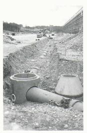
Die Kanalisation wird in einem Abstand von etwa zwanzig Metern an allen vier Gebäudeseiten entlang geführt
