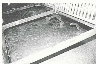
Mischen des Betons im Secatol
