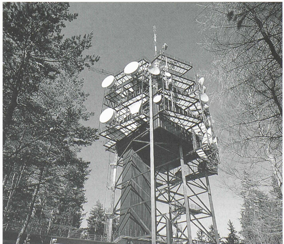
Gesamtansicht der Mehrzweckanlage Ulmizberg
