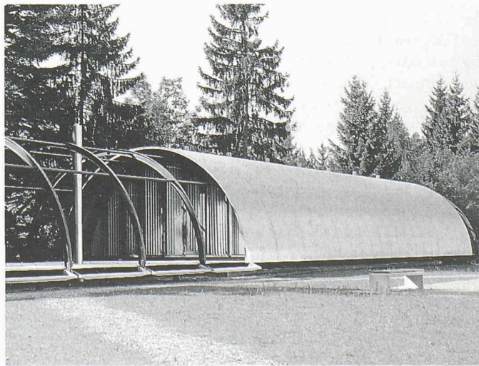
2 Mehrzweckpavillon, Aussenansicht (Bild: D. Iseli, Bern)
