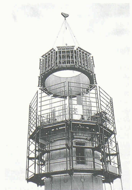
Montage der Turmschalung
