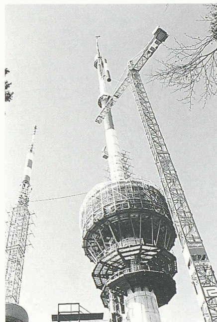
Montage des GFK-Zylinders mit der sogenannten Kletternadel
