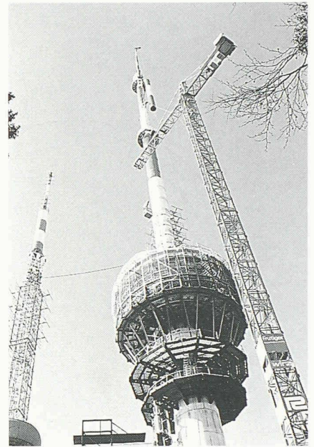
Montage des GFK-Zylinders mit der sogenannten Kletternadel
