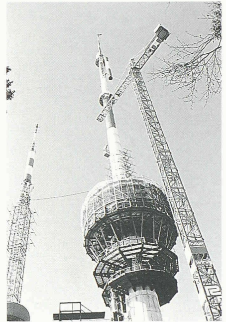
Montage des GFK-Zylinders mit der sogenannten Kletternael
