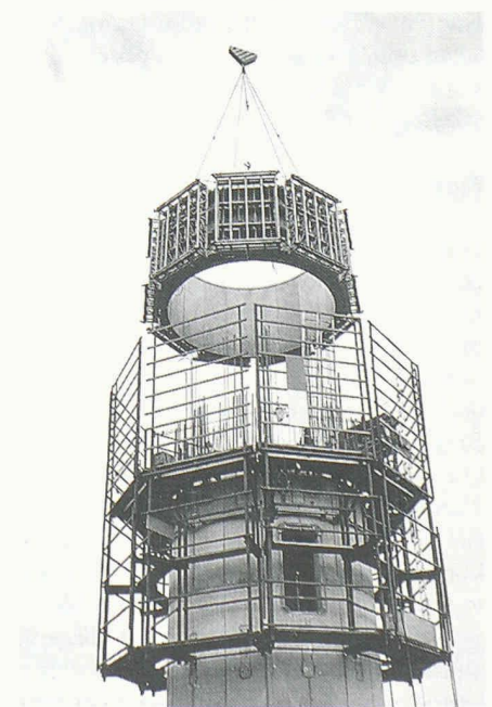
Montage der Turmschalung
