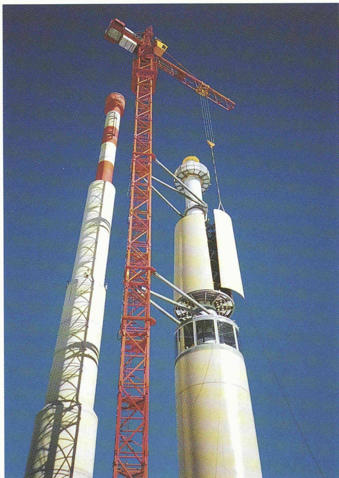
Montage der Verschallungselemente
