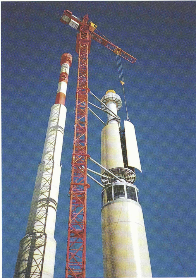
2 Montage der Verschallungselemente
