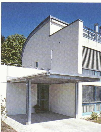
Gebogene Dachkonstruktion aus- gebildet mit Hebel-Dachplatten
