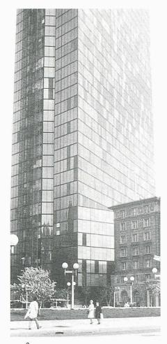
Beschädigte Fassade des Hancock Tower. Zerbrochene Glasscheiben wurden durch Sperrholzplatten ersetzt (entnommen aus «Construction Failure», J. Feld/K.L. Carper, Copyright © 1997 John Wiley & Sons, Inc. Mit freundlicher Genehmigung des Verlags John Wiley & Sons, Inc. Alle Rechte vorbehalten)
