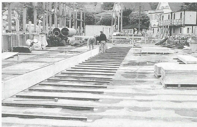
Gummi-Schwingprofile: a) im Bereich Autoeinstellhalle direkt auf Decke geklebt und b) über dem Ladengeschäft auf Mörtellager geklebt mit zwischenliegender Wärmedämmung
