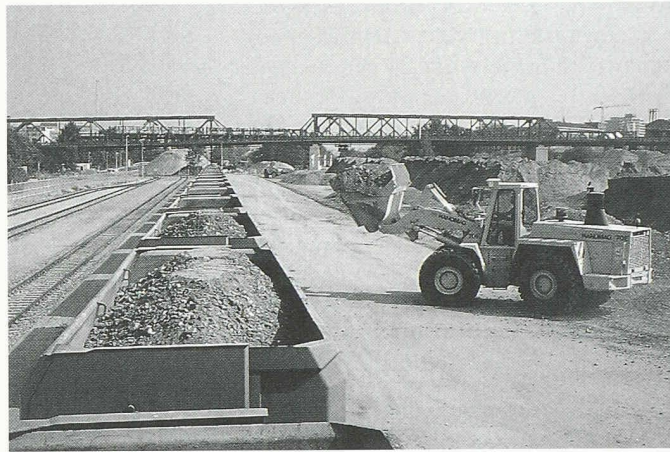
Beladung eines Erdaushubzugs
