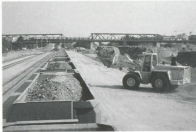
Beladung eines Erdaushubzugs
