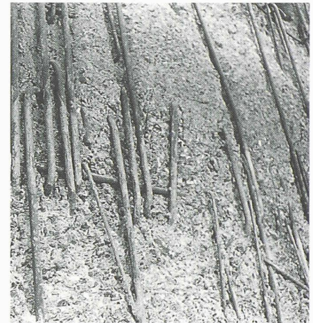
Freigelegte Bewehrung im Bereich der Turmuhr
