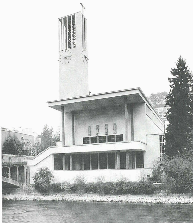
11 Südfassade der Kirche nach der Instandsetzung (Bild: N. Nager, Luzern)
