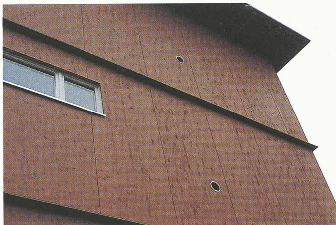
Fassadenverkleidung aus dreischichtigen Massivholzplatten mit recht dauerhafter, rot pigmentierter, wässriger Acryllasur: nach gut drei Jahren in einwandfreiem Zustand
