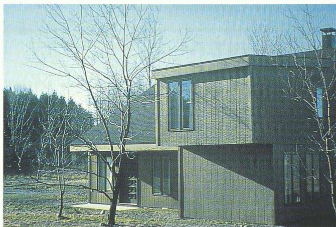
Fassadenverkleidung eines amerikanischen Einfamilienhauses (Holzrahmenbau) aus «hardboards» mit auf-geprägter Oberflächen-textur (spezielle mittelharte Holz-faserplatte)
