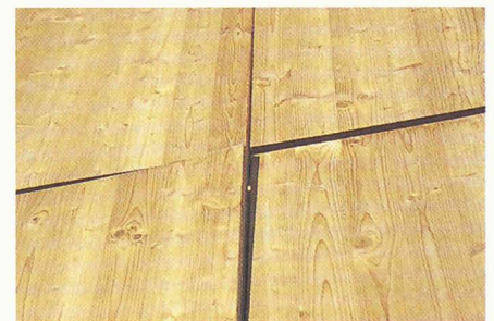
Verformte und verschobene einschichtige Massivholzplatten (Fichtenholz) als Fassadenverkleidung – für diesen Zweck nicht geeignet
