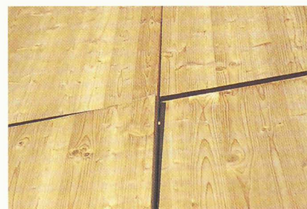
Verformte und verschobene einschichtige Massivholzplatten (Fichtenholz) als Fassadenverkleidung – für diesen Zweck nicht geeignet
