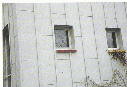
Fassadenverkleidung aus zementgebundenen Spanplatten mit deckend weissem Dispersionsanstrich (Acrylat, Wasserbasis): nach fünf Jahren in einwandfreiem Zustand
