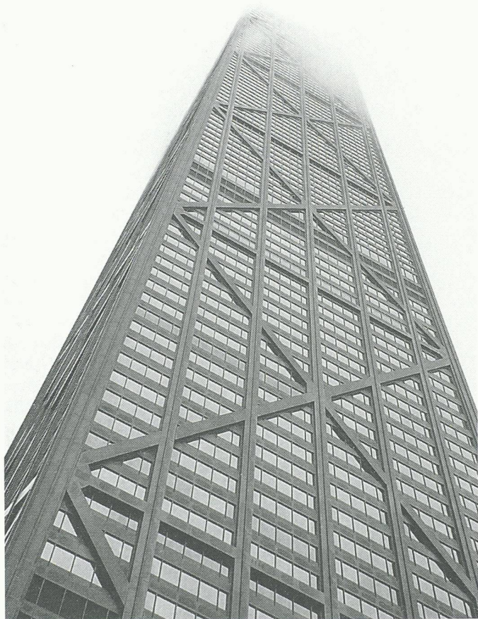
John Hancock-Center, Chicago (Ingenieur: F. Khan, Architekt: B. Graham, 100 Stockwerke). Die innovativen Stahldiagonalen dieses Wolkenkratzers erhöhen die Widerstandsfähigkeit gegen Horizontallasten. Dadurch wurde die strukturell erforderliche Stahlmenge im Vergleich zu herkömmlichen Lösungen um die Hälfte herabgesetzt. Der Kräftefluss ist an der Fassade klar abzulesen (Bild: I. Ortega)
