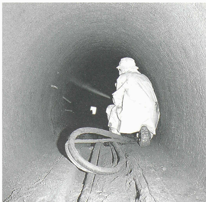
1 Spritzbetonapplikation im Abwasserkanal in der Neubrunnen- strasse in Zürich
