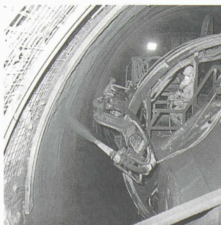
Mechanischer Spritzbetonauftrag im L2, Vereinalinie Nord (TBM)
