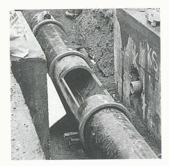
Steinzeugrohrleitung im Mittelstreifen mit Ausschnitt für Durchlaufrinne des Kontrollschachts. Seitlich erkennbar sind die für den Pressvortrieb benötigten Widerlager
