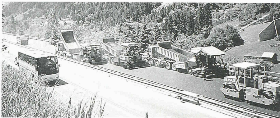
4 Nahtloser Splittmastixeinbau mit drei Einbaumaschinen auf der Spur Romeo
