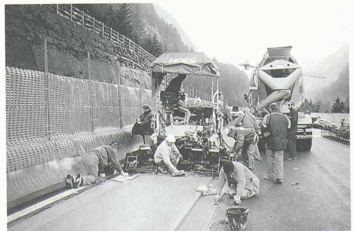
3 Einbau des Mittelstreifenbetons mit modifiziertem Asphaltfertiger (Tagesleistung: rund 150 m)
